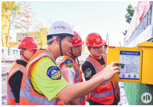
①近日，中铁二局深圳公司开展安全生产月“安安排雷”活动，组织基层群安员、青安岗围绕高空作业、临时用电、消防设施等环节，排查治理安全隐患。 贾玲 王志祥 摄影报道
