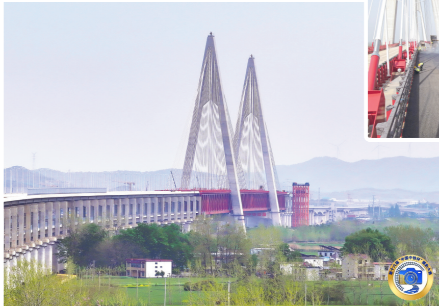
4月10日,中铁四局负责的巢(湖)马(鞍山)城际铁路马鞍山长江公铁大桥副汉航道桥沥青铺装任务全部完成。该副汉航道桥为世界最大跨度无砟轨道三索面钢桁梁斜拉桥,长840米,摊铺面积达22778平方米。
