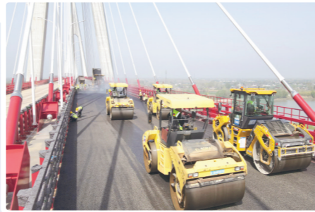
4月10日,中铁四局负责的巢(湖)马(鞍山)城际铁路马鞍山长江公铁大桥副汉航道桥沥青铺装任务全部完成。该副汉航道桥为世界最大跨度无砟轨道三索面钢桁梁斜拉桥,长840米,摊铺面积达22778平方米。
