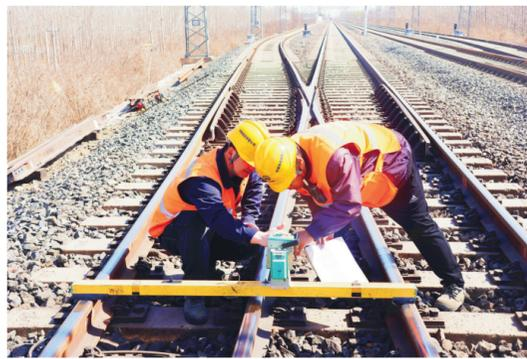
9月初以来,中铁电气化局运营公司鄂黄公司组织开展“送课下基层 助力鄂黄”培训工作,通过技术骨干“我演你学”“你练我看”的方式手把手教学、一对一指导,着力提高基层员工的专业技能水平和抢修能力。图为接触网专业技术骨干杨培岗(左)对一线员工李晚腾(右)进行接触网线索静态测量现场教学。 张嘉希 摄
