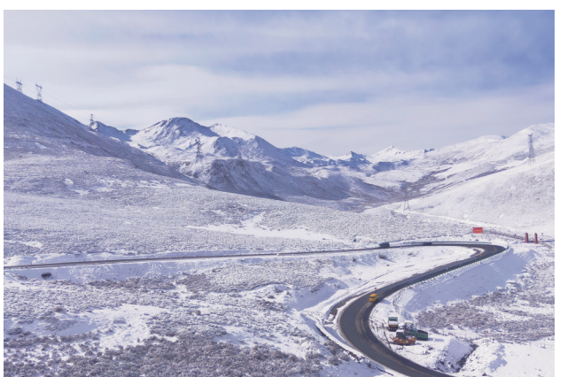
4月27日,中铁五局成都公司承建的G318线大中修项目折多山山顶沥青路面摊铺提前3天完成。该项目位于折多山区,海拔4200米,虽仅长4公里,却是甘孜州十余个市县进出的重要道路。王松 曾松 摄影报道
