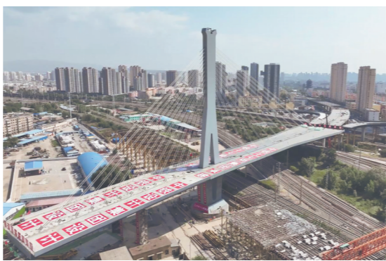
9月21日,中铁设计集团设计的山西大同平城街西延跨铁路桥主桥成功转体,刷新国内转体桥梁两端重量不平衡、桥面变化最大纪录。主桥长254米,布置为91米+163米,为独塔双索面斜拉桥,梁面宽从26.5米渐变至40.1米,转体重量25000吨,重量和跨度均居世界前列。高志雄 郭晓霞 摄影报道
