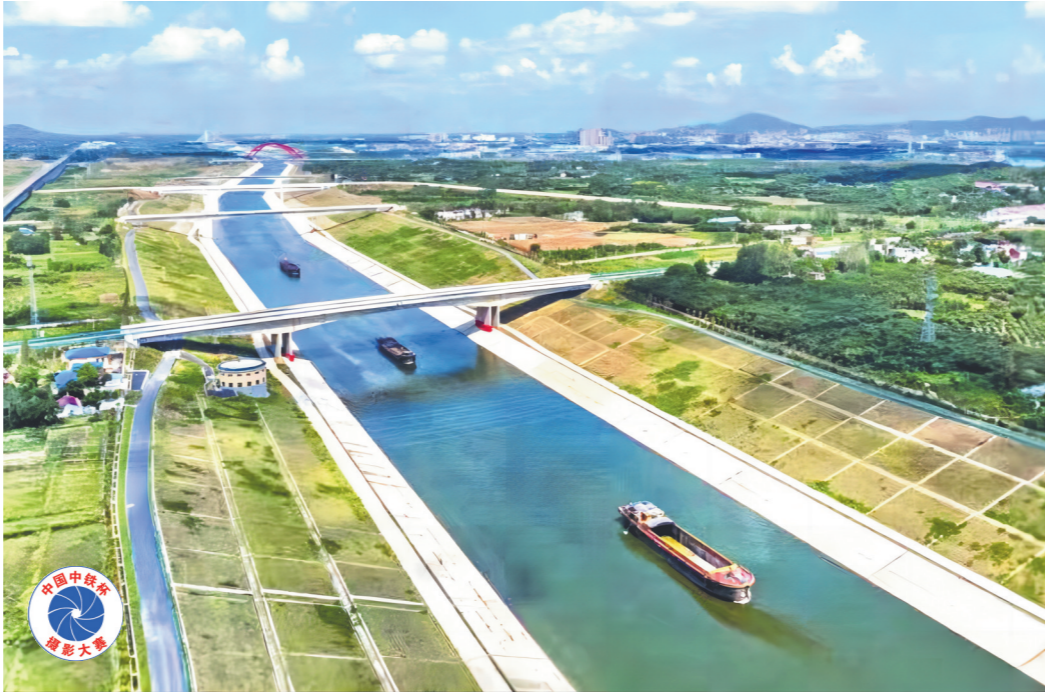
近日,中铁十局参建的引江济淮菜子湖线试运行,至此全长354.9公里的引江济淮一期航运工程全线通航。引江济淮工程连通长江与淮河,是集供水、航运、生态效益于一体的大型跨流域调水工程。此次试运行的菜子湖线全长131.2公里,巢湖侧为上游,长江侧为下游,设计通航船舶为1000吨级,兼顾2000吨级。
