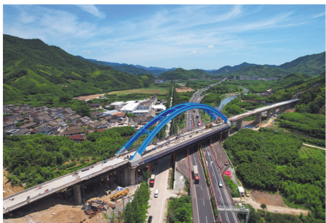
近日，中铁五局承建的全首铁路最大跨度系杆拱——溪口特大桥144米系杆拱顺利完工。该桥全长523米，跨内金高速公路、S309省道，施工难度大、安全风险高。 陈华杰 何万林 谭武军 摄影报道
