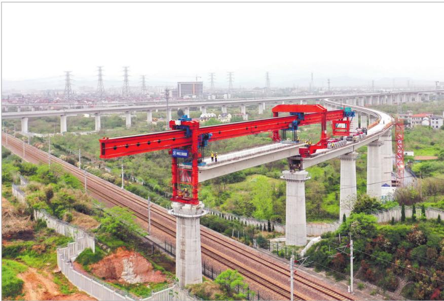
近日,中铁三局施工人员完成了杭衢铁路(建衢段)九景衢下行联络线特大桥上跨衢九铁路架梁施工。杭衢铁路连接浙江省杭州市与衢州市,主线全长130公里,设计时速350公里。中铁三局负责杭衢铁路站前4标工程建设,管段位于衢州市。本次箱梁架梁施工是在400米小半径曲线、大坡道、有限封锁时间工况下完成,施工难度大、安全风险高,在国内铁路建设中较为罕见。
